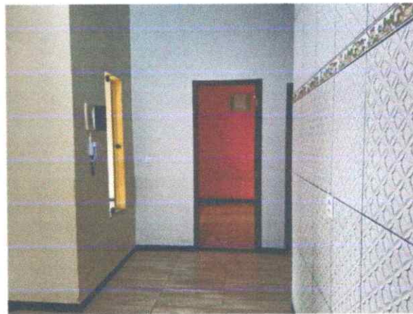
Imagem 10: Revestimento em pintura
