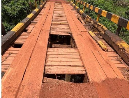
FOTO 19 - Construção de Ponte da Estrada do Km 74 Ponte 1
