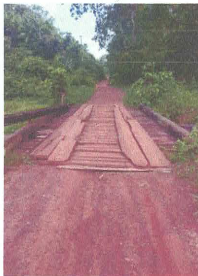
Imagem 14: Ponte da Região da PA/MA
