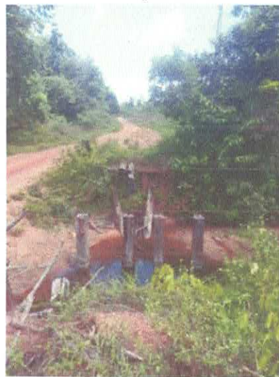
Imagem 13: Ponte da Vila de São Jose do Piria.
