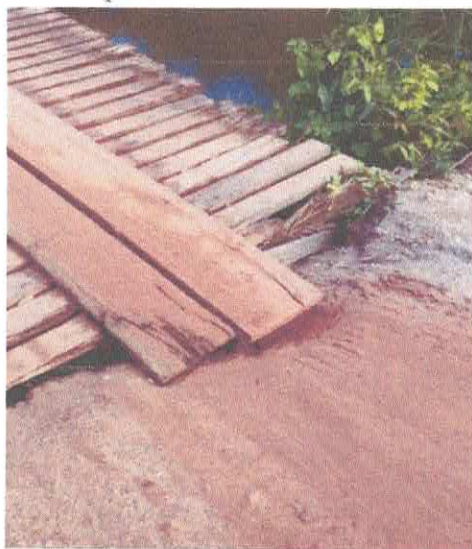
Imagem 22: Ponte da Região da PA/MA
