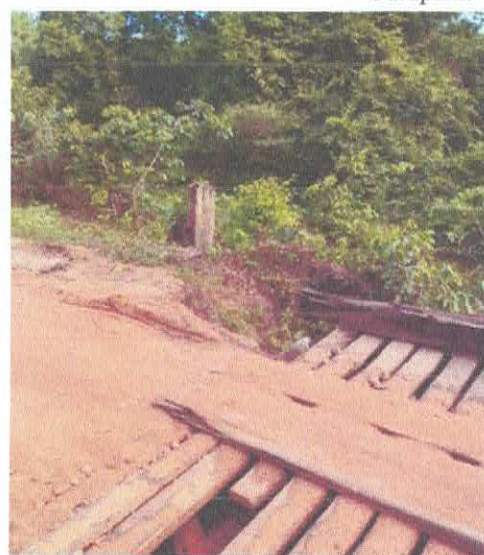
Imagem 23: Ponte da Região da PA/MA
