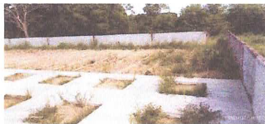
Foto 02 - Vista da Quadra
