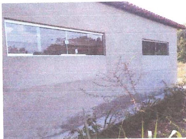
Foto 09-Vista fundos (sala de aula)
