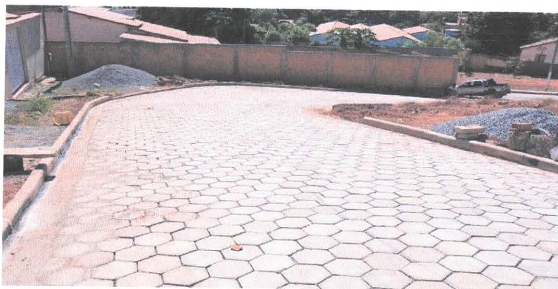
02 – Pavimentação em execução.
