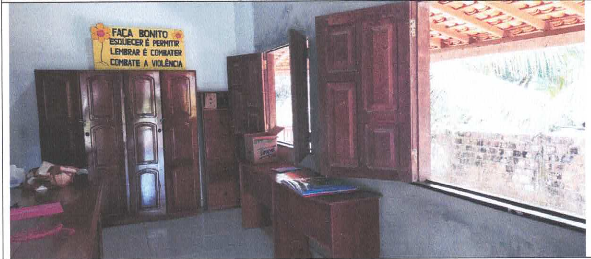
FOTO 07 – SALA DE 1 (VISTA DA PAREDE DIREITA)
