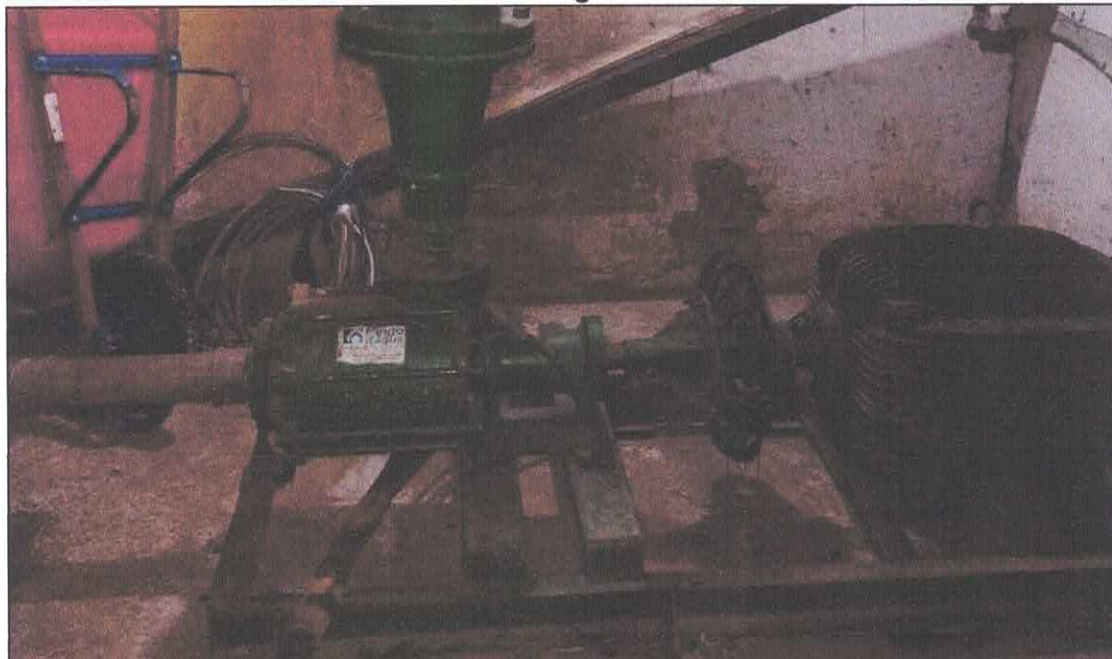
Foto 4: Bomba centrífuga de eixo horizontal.
