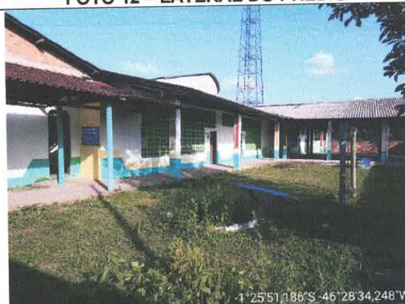
FOTO 12 – LATERAL DO PRÉDIO
