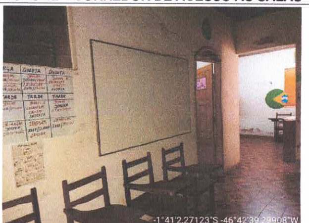
FOTO 12 – CORREDOR DE ACESSO AS SALAS
