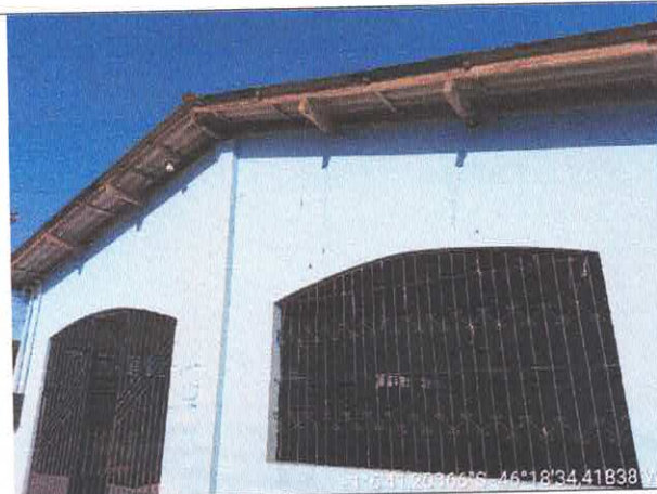
FOTO 03 – CORREDOR DE ACESSO AS SALAS E ESTRUTURA DA COBERTURA DE MADEIRA E TELHA CERÂMICA
