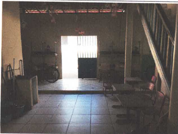
FOTO 11 – ÁREA DE ACESSO AO 2 PAV.
