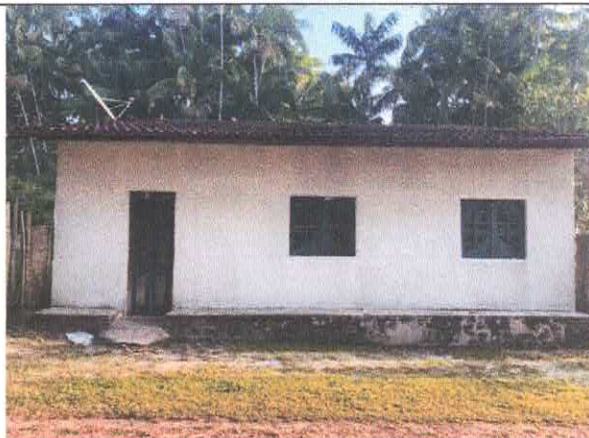
FOTO 01 – ENTRADA DO PRÉDIO
