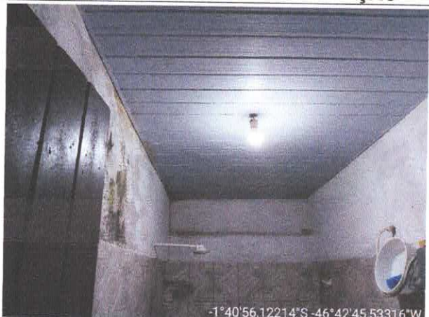
FOTO 05 – MANCHAS DE INFILTRAÇÃO
