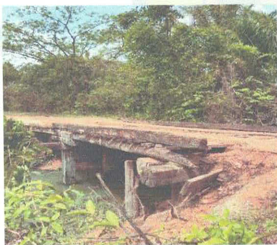
Foto 1 Ponte Sobre o Igarapé do Raul
