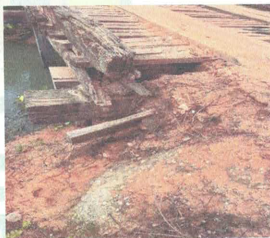
Foto 2 ponte sobre o Igarapé do Raul
