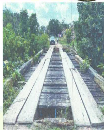
Ponte da Região da PA//MA
