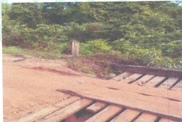
Ponte da Região da PA/MA
