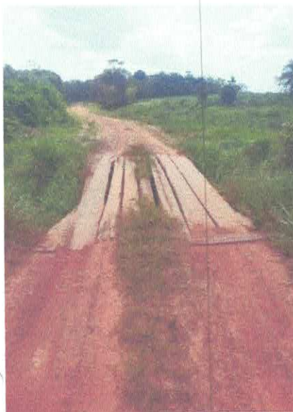
pontilhão da Vila de Curupaiti
