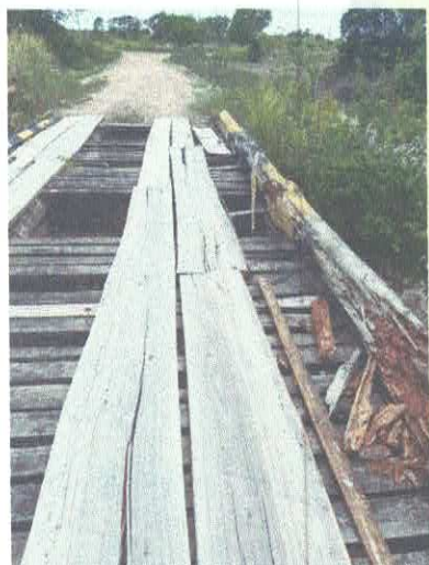
Ponte da Vila do Taboquinha
