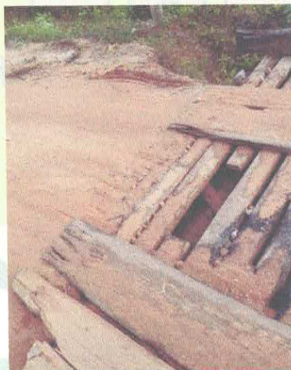
Pontilhão da Vila de Curupaiti
