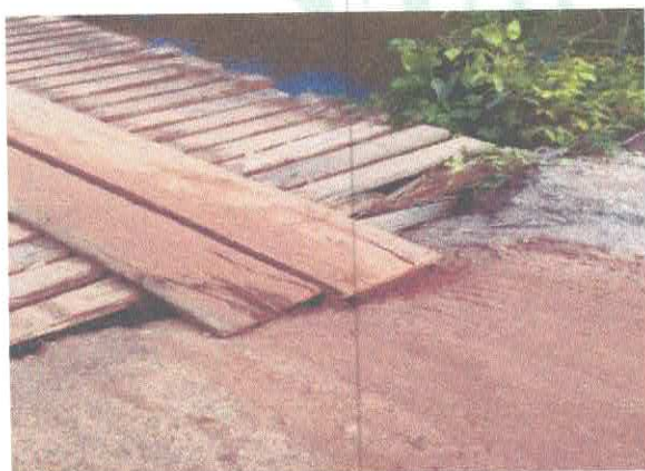
Ponte da Região da PA/MA
