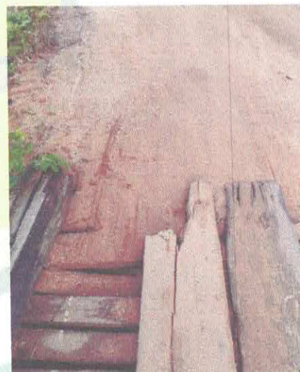
1Pontilhão da Vila de Curupaiti
