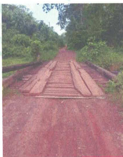
Ponte da Região da PA//MA
