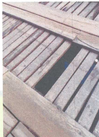
Pontilhão da vila Enseada
