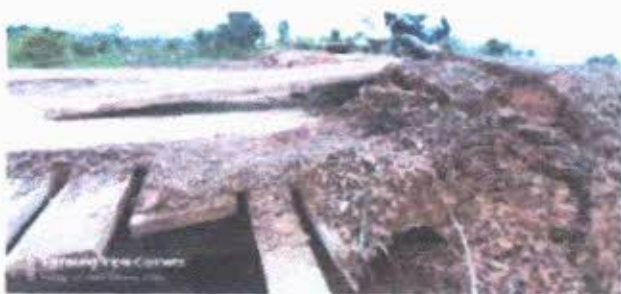
FOTO 03: Ponte na estrada do Cristal
