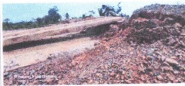
FOTO 02: Ponte na estrada do Cristal
