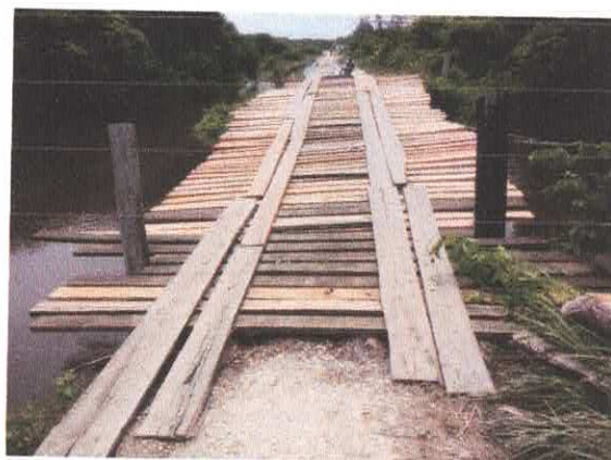
FOTO 18 - PONTE DO CARRAPATINHO
