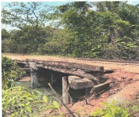
Foto 1 Ponte Sobre o Igarapé do Raul
