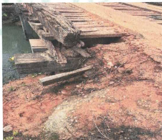
Foto 2 ponte sobre o Igarapé do Raul
