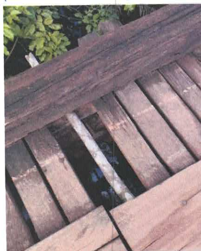
Pontilhão da Vila de Curupaiti
