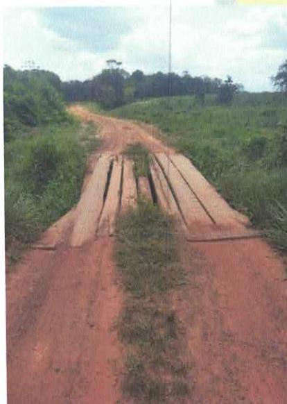
pontilhão da Vila de Curupaiti
