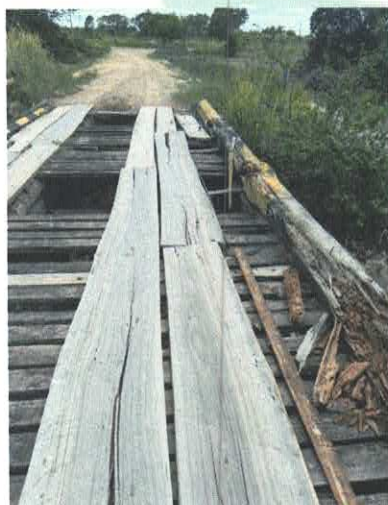
Ponte da Vila do Taboquinha
