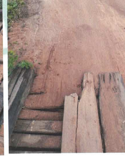
1Pontilhão da Vila de Curupaiti
