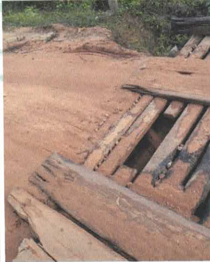
Pontilhão da Vila de Curupaiti
