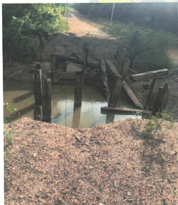
Ponte da Vila do Laguinho
