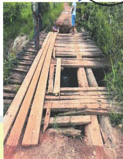
Ponte Rua Nova
