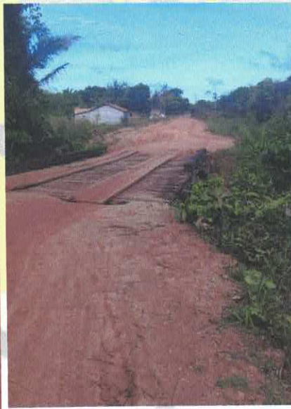
Ponte da Região do 2º Distrito
