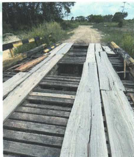
Ponte da Vila do Taboquinha
